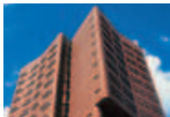
Alloggi per ufficiali dei Royal Marines Olandesi, Den Helder, NL Van Herk & de Kleijn Architecten BV, Amsterdam Ridder BV, Hoorn TECU® Classic
