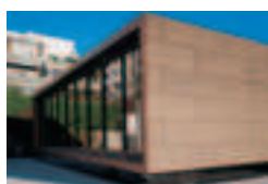
Banca BTV, Innsbruck, A Hanno Vogl-Fernheim, Innsbruck Spenglerei & Glaserei Anker, Hall TECU® Bronze_mesh
