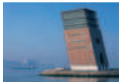
Torre di Controllo del Porto di Lisbona, P Gonçalo Byrne, G.B. Arquitectos, Lisbona Zn-Revestimentos de Zinco Lda., Maia TECU® Classic
