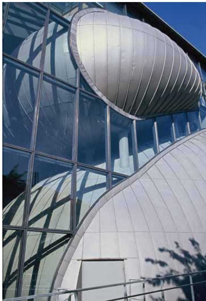
Scuola di diritto, Limoges (Francia) - Architetto: Fuksas
