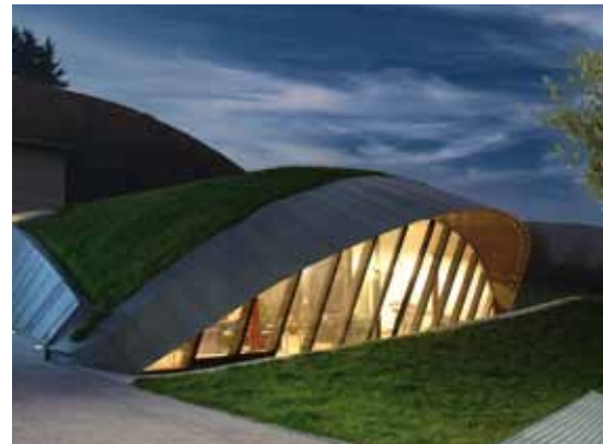
Cantina Barolo (Barolo CN - Italia) - Architetti : Studio Paolo y Ugo Dellapiana, Francesco Bermond des Ambrois
